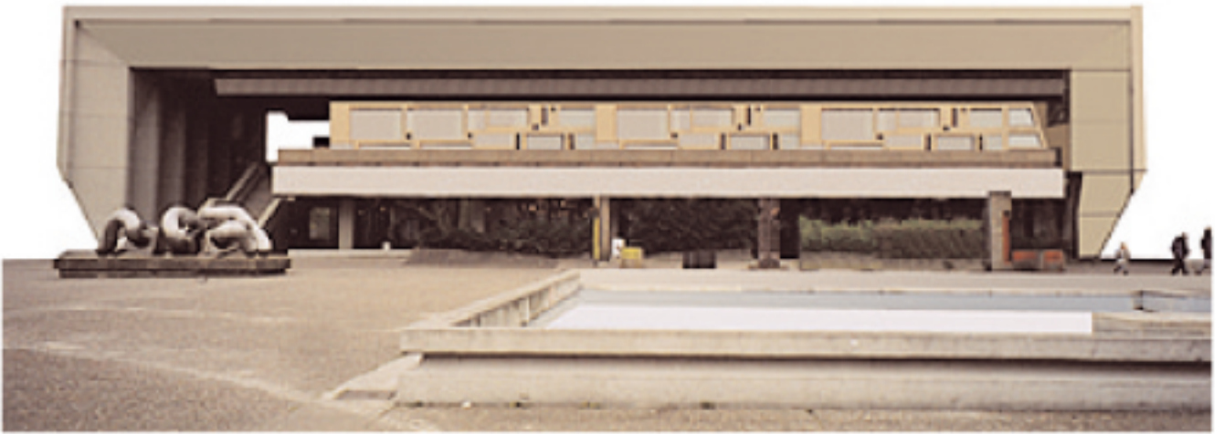
Sitzungstrakt des Marler Rathauses mit (↑) und ohne (↓) Dachkonstruktion.
